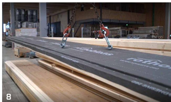
8 Os painéis preparados desta forma são facilmente transportados para a obra.
