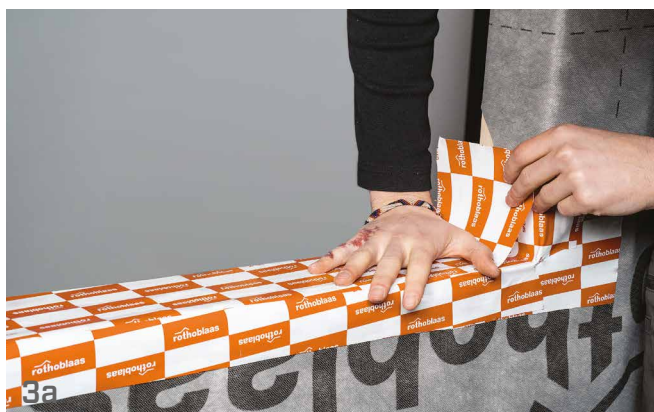
Selar a janela com fita adesiva Rothoblaas.
