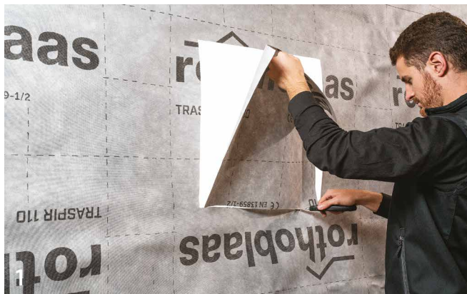
Cortar as aberturas das janelas.
