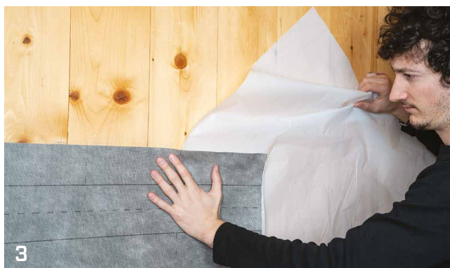
3 Remover a camada de separação e fazê-la aderir ao suporte de cima para baixo.
